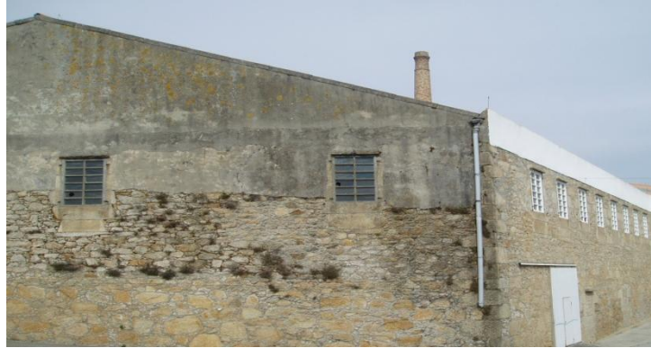
Pinche e fachada principal rehabilitada do secadoiro de congro
